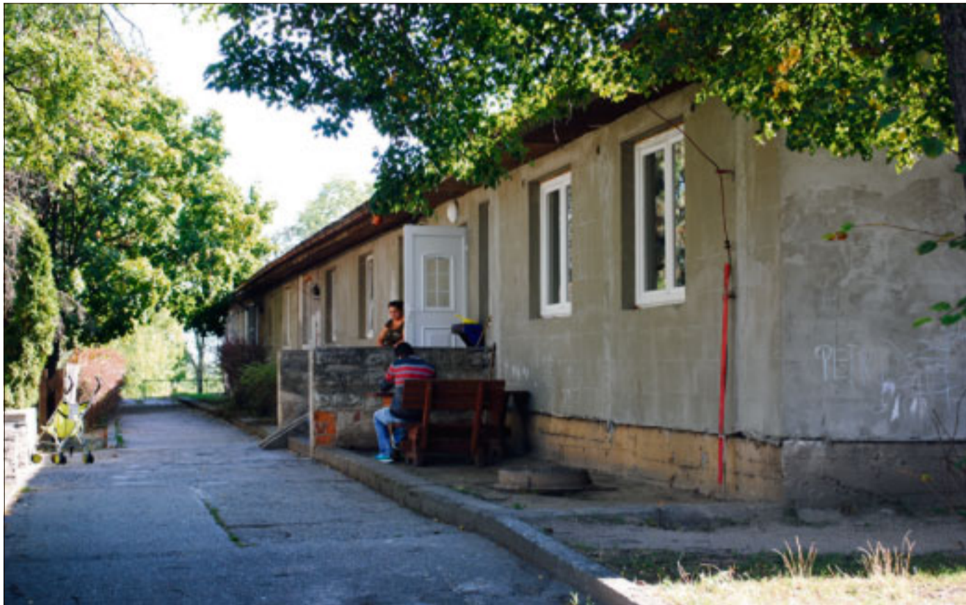
Herberge mit provisorischem Charakter: Die Familien sind in Baracken untergebracht.
